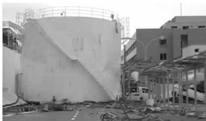
Figura 5 e 5a, I grandi serbatoi di gasolio sono spazzati via e spostati a decine di metri di distanza
